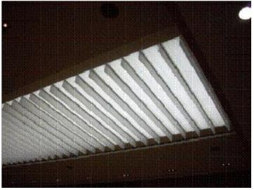
スリムなライン上の膜パネルには、TONYの特別なアルミの型材が使用されています。 フレームの影が出やすいのですが、とても綺麗に発光しています。
