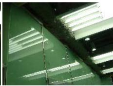
内部には、光膜パネル(E-クロス) を面発光させる一般的な蛍光灯と 膜パネル(S-クロス)を部分的に薄 らと光らせるダウンライトが配置され ています。
