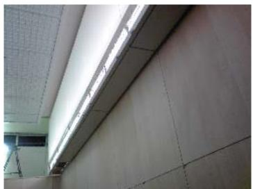
パネル工法とは異なり継ぎ目が非常にきれいに 仕上がりました。また超軽量なので地震にも強 く一般の建材としても膜を使用した壁としても 使用できます。不燃材認定品なのであらゆる用 途に使用できます。次世代の建材として注目い されています。
