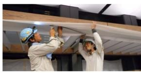
このプロジェクトで使用している、嵌め合いタイプの「Fit System」は、施工後に照明器具のメンテナンスを行うことを考慮し「脱着タイプ」が採用されました。
