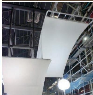
最大 $5\text{ m} \times 30\text{ m}$ のパネルを現地張りしました。内Rなので実物大のモックアップを行い検証をしました。
