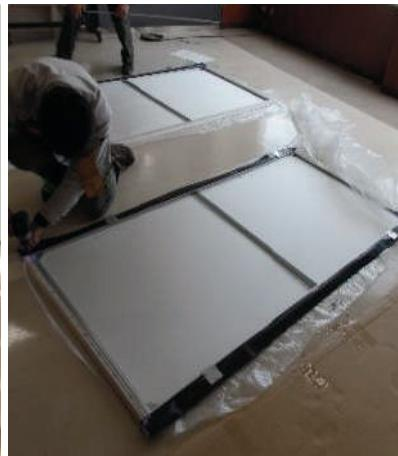
国内で $2\text{ kg/m}^2$ 以内で初めて施工された、エントランスホール。煙探知機・スプリンクラー・スピーカーなどの設備機器も簡単に設置できます。パネル間の目地も不燃膜を使用しているので超軽量です。
