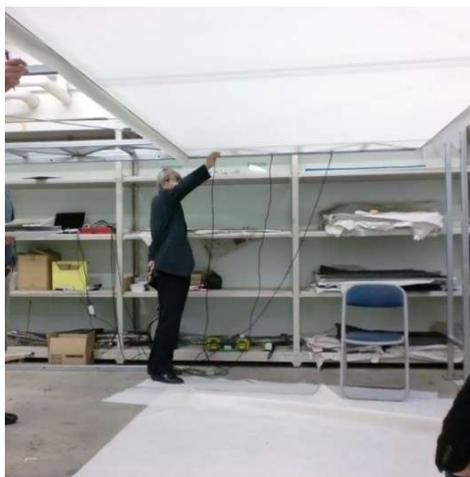
はじめに2方向(長手)のみをボルトまたはジャッキ等で機械的に引っ張り込み、両サイドは少しの張力で簡単に固定する工法
