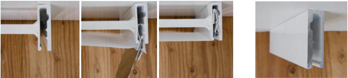
これまでの嵌め合い工法は、工場で固定樹脂を熱溶着していたので、現場での寸法が合わず、引っ張りすぎて破断したり、長すぎて弛んだりしました。Fit Systemは、現場での調整が可能になりました。
