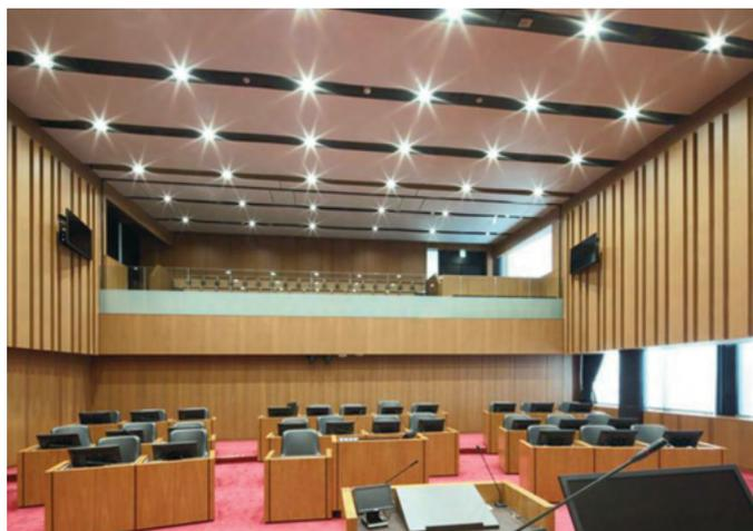
【木目調膜パネル 超軽量の木目調の不燃膜。膜パネル工法なので2kg/m<sup>2</sup>以内】
