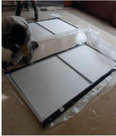
国内で2kg/m<sup>2</sup>以内で初めて施工された、エントランスホール。煙探知機・スプリンクラー・スピーカーなどの設備機器も簡単に設置できます。パネル間の目地も不燃膜を使用しているため超軽量です。
