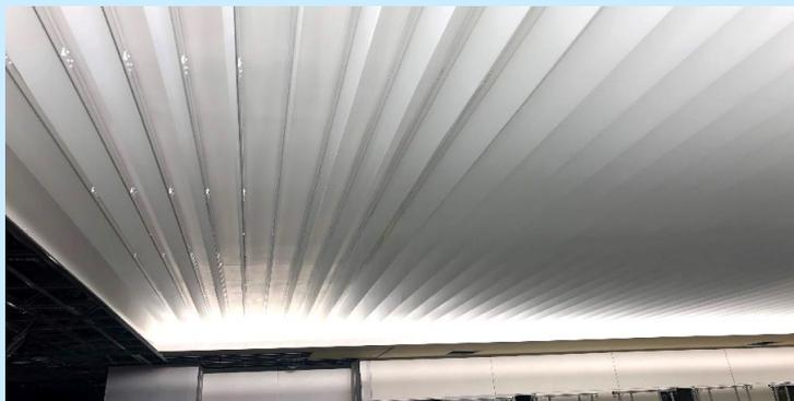
■大型光膜天井・・・生地巾=3Mの膜を開発。1枚ものの大型光膜天井が実現しました。
