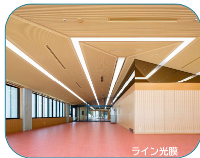
色試作を何度も繰り返し、見事に周囲と調和した2,000本ものルーバー光膜
