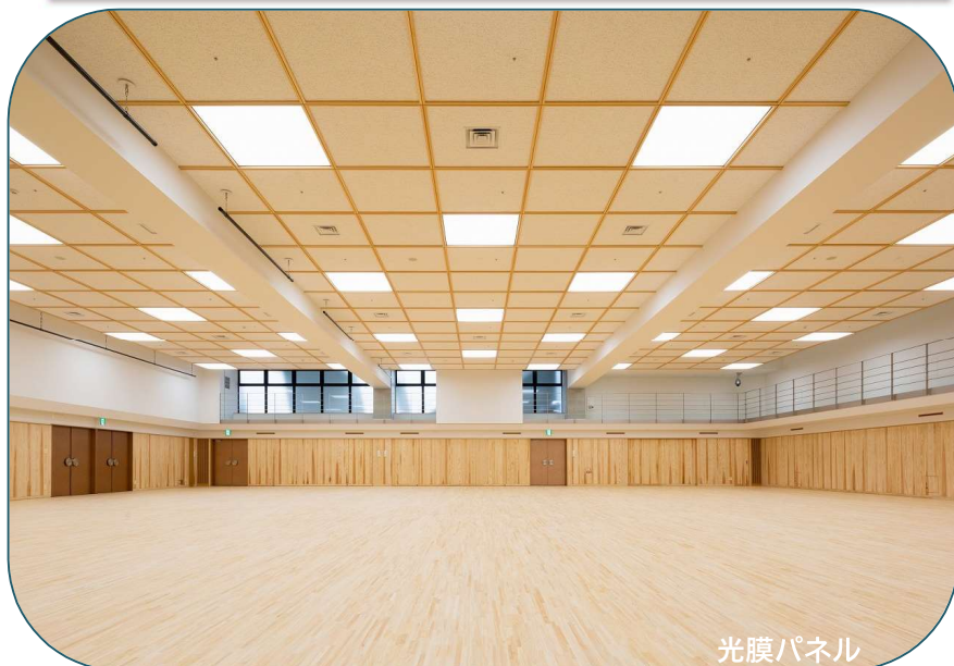
色試作を何度も繰り返し、見事に周囲と調和した2,000本ものルーバー光膜
