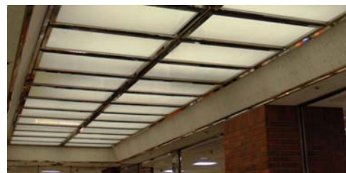
改修前の光天井
