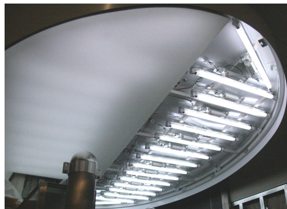
パネルを開けて下からメンテナンス
