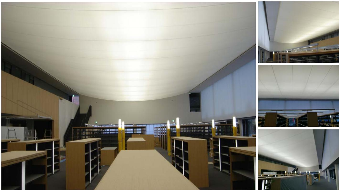
図書室内部。天井：懸垂型one-way光膜、壁：膜タペストリー。
